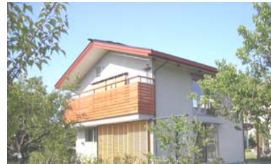
NO4住宅; 石油系住宅メーカーのモデルハウスと一線を画す仕様
