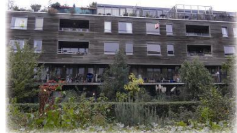
北側断熱は煉瓦タイルと3層ガラスで閉じ、南側開口から日射を入れた板張り
