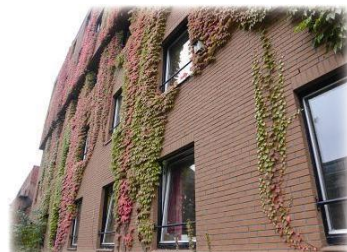
北側断熱は煉瓦タイルと3層ガラスで閉じ、南側開口から日射を入れた板張り
