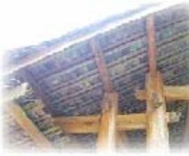
柱の仕口と屋根の構造
