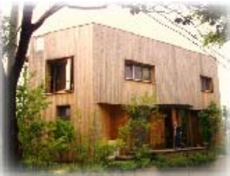
ラ-チの外壁は無塗装、グレーに変化する
