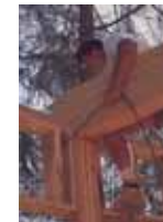
日本の2x4とは明らかに違い太いティンバーフレームも多用されている。住宅寿命の長さを感じる。
