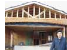
ガレージ改築中(カーソン地区)
